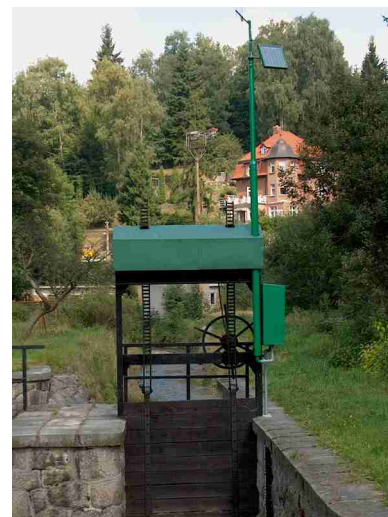
MS vně stávajícího objektu
